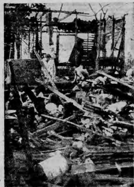
DESASTROSO INCENDIO EN PAVAS. —Dejó por el suelo la residencia de dos humildes familias que perdieron casi todas sus haberes. En la foto vecinos de Pavas, donde ocurrió este siniestro, buscan entre los escombros objetos que llevar a sus casas. (Foto Lizano)
